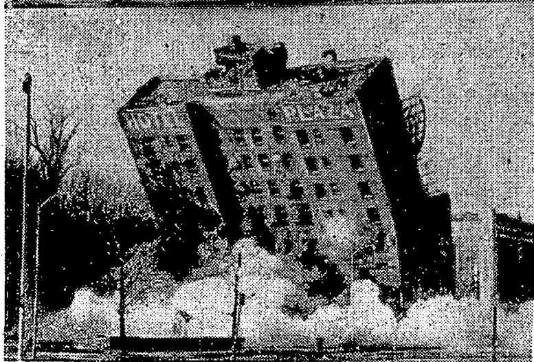
Este es el edificio de nueve pisos del Hotel Plaza, destruido por la explosión de la dinamita colocada en su base y primer piso. Fue construido hace 48 años y en su lugar se edificará otro nuevo. Su derrumbamiento sólo costó 17 segundos.— (Foto Upi—Cifra)
