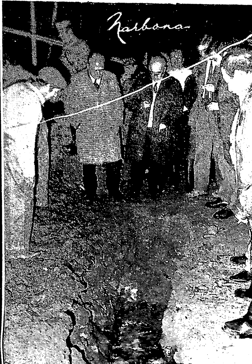
En la noche del pasado miércoles, el alcalde de La Línea, algunos concejales y técnicos municipales, estuvieron presentes en los trabajos de canalización del agua procedente de Sierra Carbonera, para evitar inundaciones en un sector de La Atunara. En la fotografía, el señor Alfageme González y acompañantes observan la construcción de una zanja hacia un colector.-(Foto Narbona)
