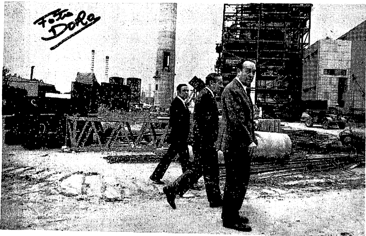
Al fondo, una parte de lo que es la Central Térmica de Puente Mayorga, una de las nuevas grandes realidades del Campo de Gibraltar. En primer plano, el presidente del Consejo de Administración y el director general, que recorren las instalaciones.
