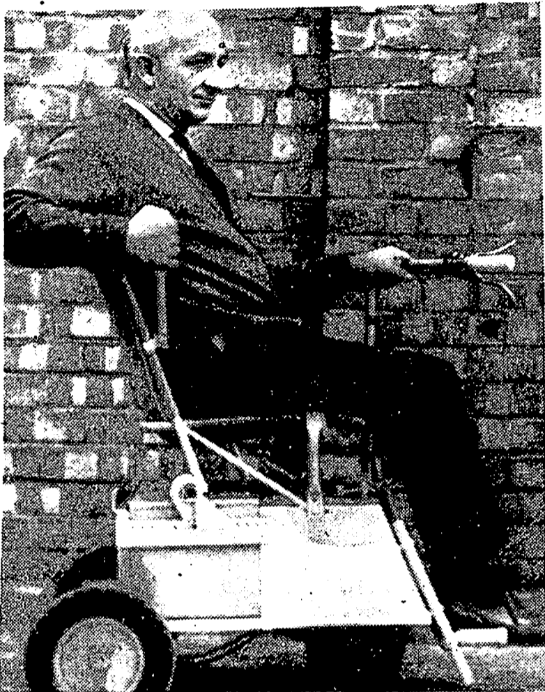
Esta silla, propulsada por baterías, ha sido inventada especialmente para ayudar a los invalidos. Su inventor, H. Besume, realiza una demostración y ha dicho que puede rodar fácilmente sobre carreteras, caminos, hierba, tierra, etc. a una velocidad de hasta 8 kilómetros por hora. (Foto Cifra)
