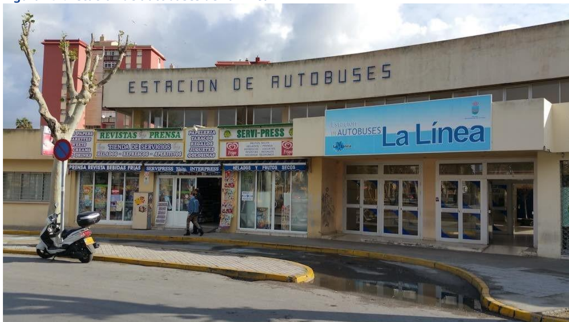
Figura 187. Estación de autobuses de La Línea
